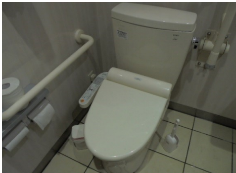
ルーム内の床面が濡れていました
