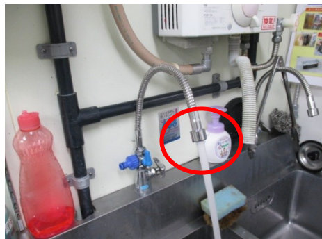
根元に分岐金具を設置します
